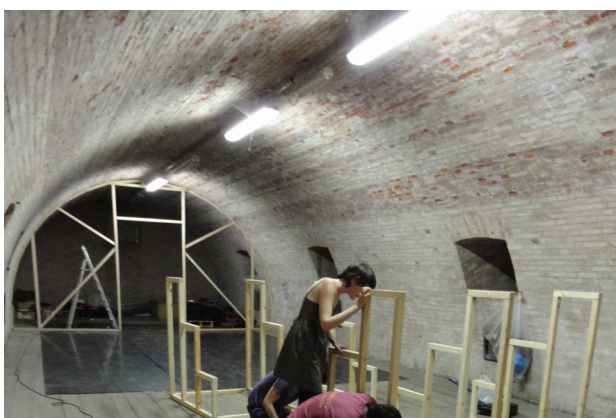
Costruzione delle gradinate;
