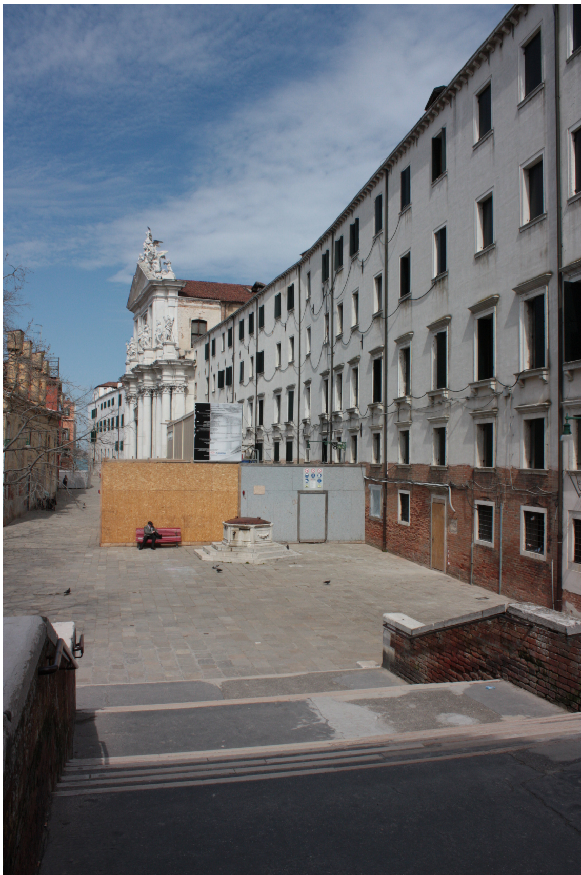
Figura 5: provenendo da Sud, dal ponte dei Gesuiti il complesso si manifesta in tutta la sua compatta mole, costituendo la quinta principale del campo antistante. Così come nei suoi prospetti lungo i canali contermini, i Crociferi si presentano come una fabbrica massiccia, lineare e chiusa in sè stessa. Un sobrio blocco monolitico all'interno di un tessuto urbano più minuto e composito.
