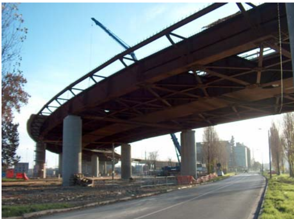
Figura 3: Sviluppo spaziale della struttura d'impalcato in fase di costruzione con vista della parte intradossale dalla quale si notano sia i profili principali che i sistemi laterali tirante-puntone.
