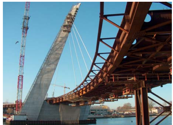
Figura 3: Sviluppo spaziale della struttura d'impalcato in fase di costruzione con vista della parte intradossale dalla quale si notano sia i profili principali che i sistemi laterali tirante-puntone.
