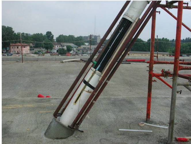
Figura 8: Posizionamento dei sensori SOFO negli stralli
