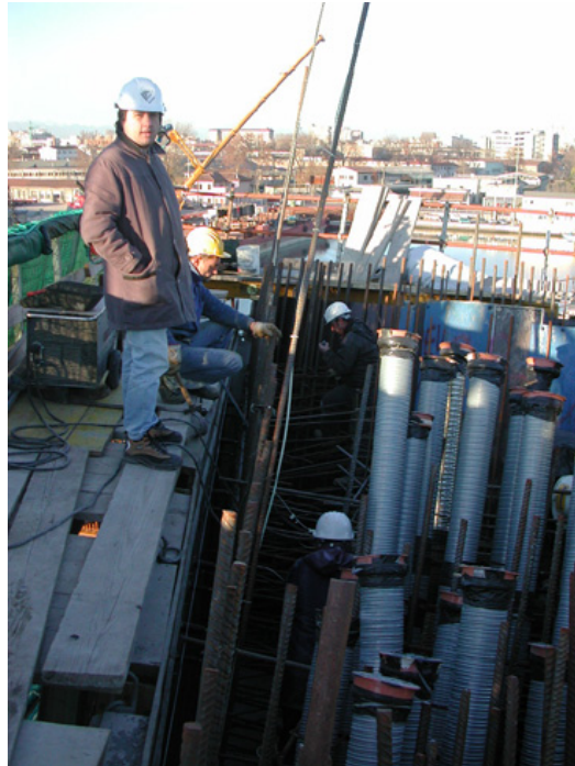
Figura 7: Posizionamento dei sensori SOFO nell'antenna prima del getto
