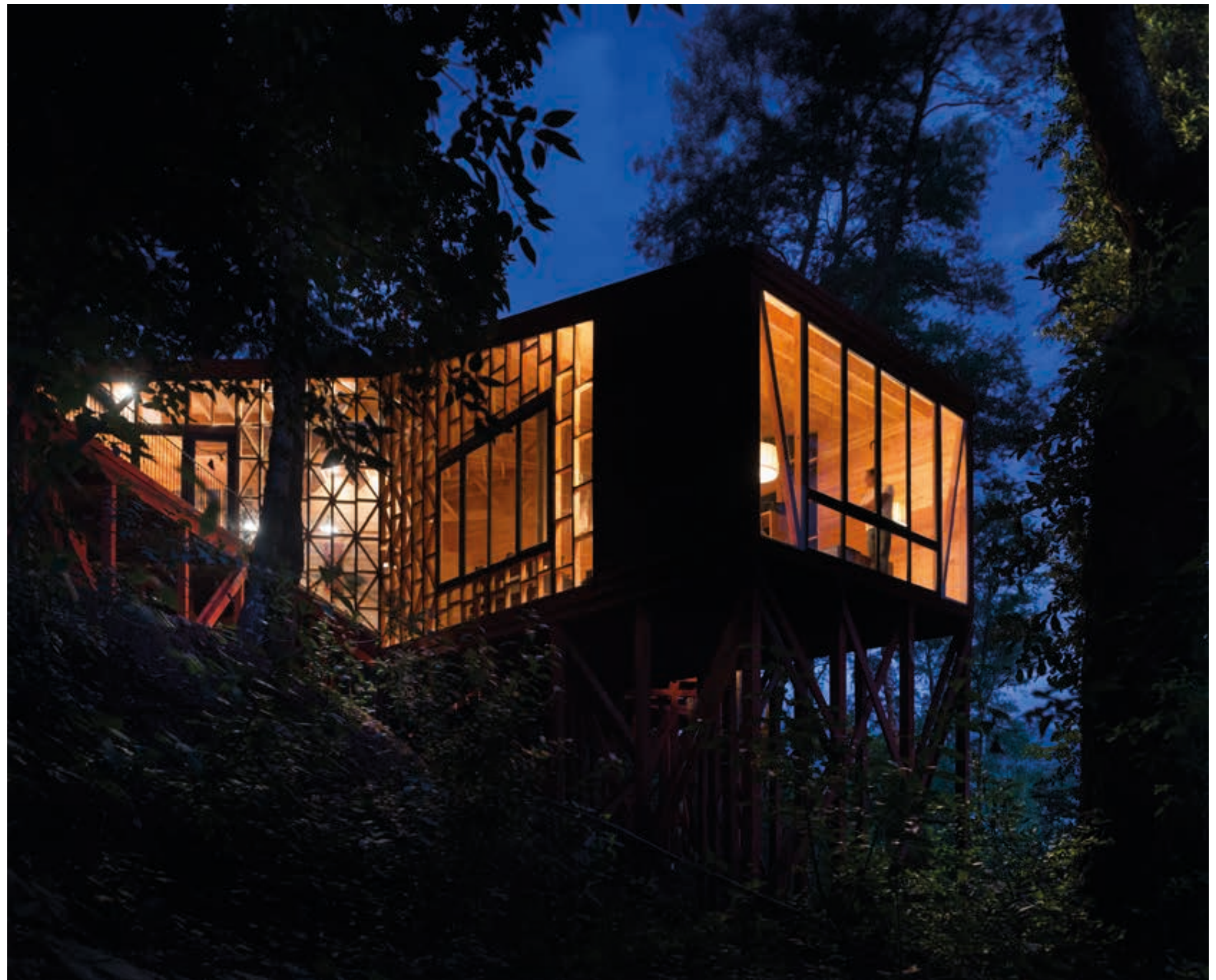
Sebastián Irarrázaval, 2Y House, l'edificio visto dal bosco di notte | night view of the building from the wood, lago Colico. Ph. Felipe Diaz Contardo, 2016.
