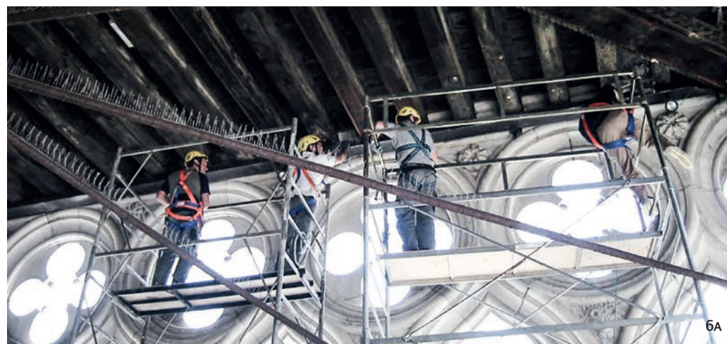
5 Fase di installazione di sensori accelerometrici per il monitoraggio in continuo dinamico del macro-elemento tamburo-cupola della Chiesa di Santa Maria del Suffragio, colpita dal terremoto del 2009 a L'Aquila
