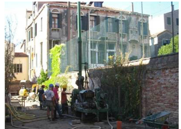
posizione sonde geotermiche
