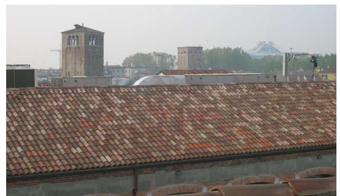
vista dell'area dalla terrazza impianti
