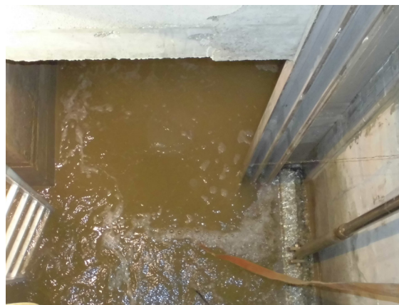
la camera di presa acqua laguna
