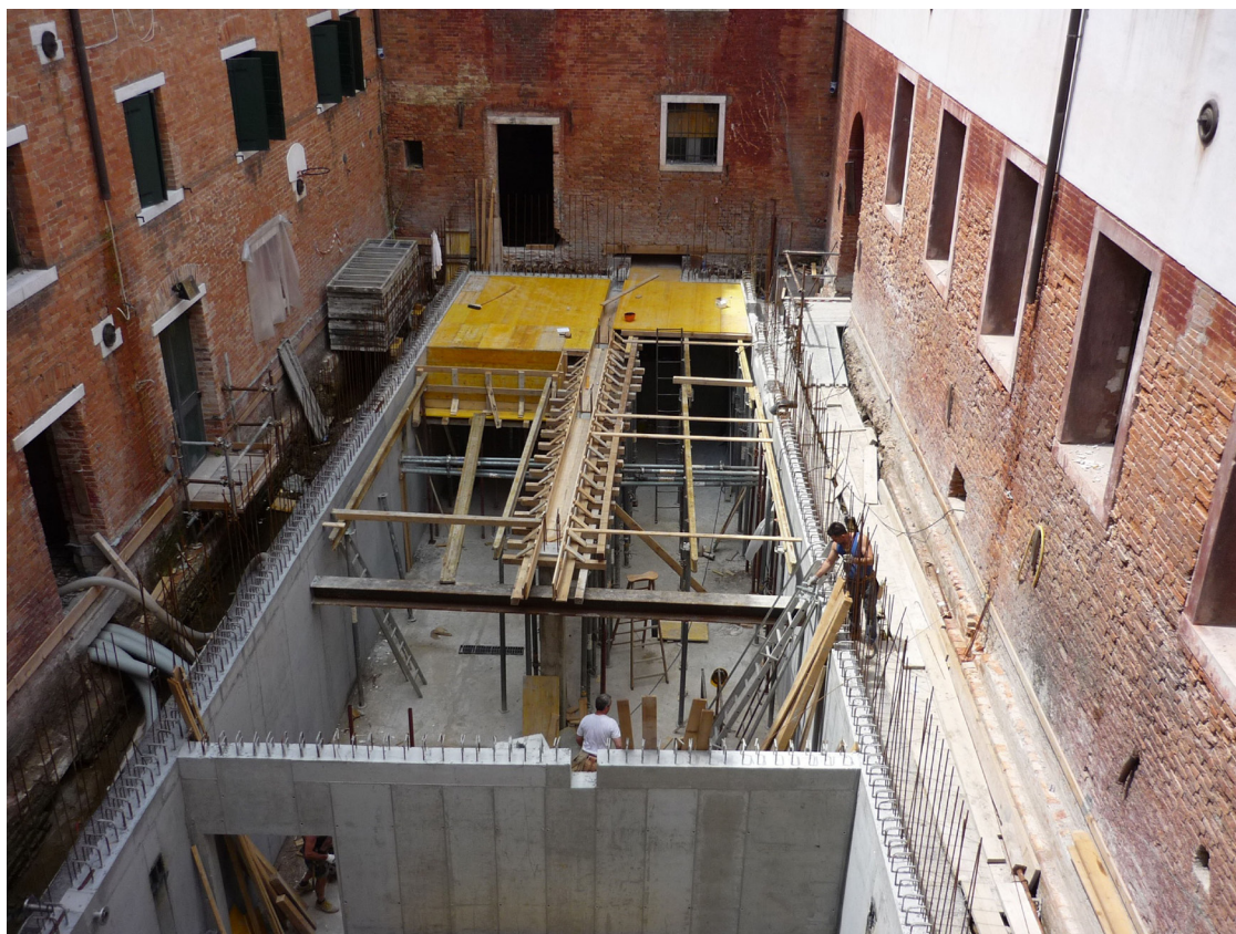
scavo centrale sotterranea
