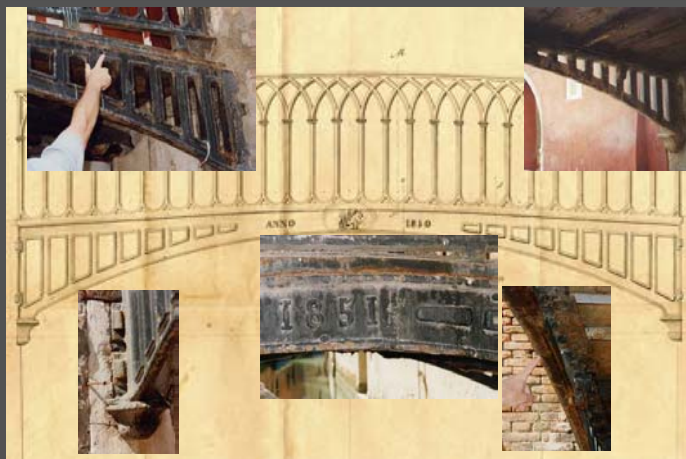
Prospetto del progetto originale e rilievo fotografico del danno
