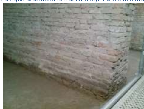
Ripresa nel visibile della base di uno dei setti di sostegno presenti nel Cenobio.
