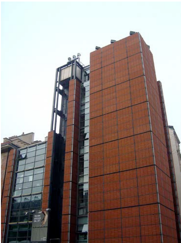
Estensione dell'IRCAM, Institute of Contemporary Research on Acoustics and Music, del Centro Pompidou a Parigi, 1988-1990, Renzo Piano. I laterizi che costituiscono il rivestimento della facciata sono connessi a secco mediante cavi in acciaio fissati ai pannelli metallici.
