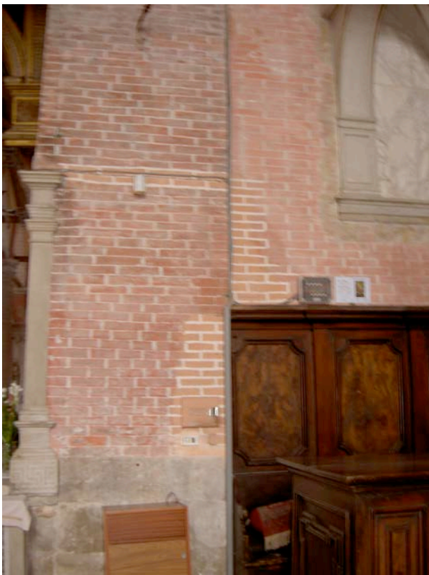
Chiesa di San Nicolò dei Mendicali, una tra le più antiche e popolari chiese di Venezia, fondata probabilmente nel VII secolo e, più tardi, ricostruita e modificata a più riprese. Particolare del rivestimento eseguito secondo la tecnica del regalzier.
