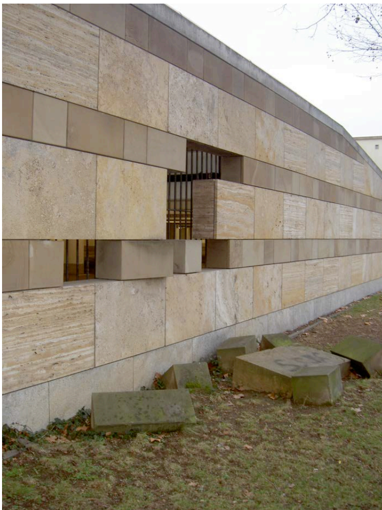
Staatsgalerie, Stoccarda, James Stirling, 1977 (concorso)-1984. Particolare dei blocchi abbandonati a terra che svelano la natura di rivestimento delle pietre in travertino e arenaria con cui è realizzata la pelle dell'edificio.
