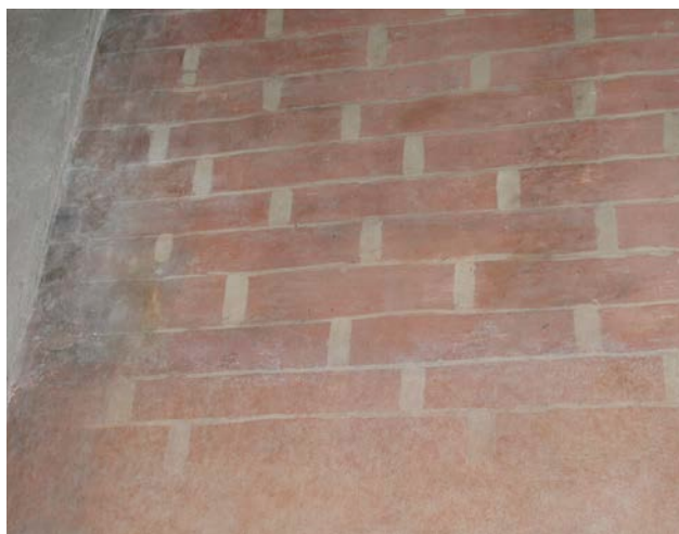
Chiesa di San Nicolò dei Mendicali, una tra le più antiche e popolari chiese di Venezia, fondata probabilmente nel VII secolo e, più tardi, ricostruita e modificata a più riprese. Particolare del rivestimento eseguito secondo la tecnica del regalzier.
