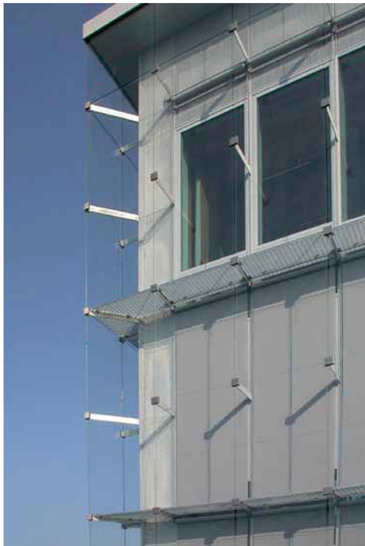
Sotto, Sede Homes, Pieve di Soligo, Treviso, arch. Mario Mazzer. Tende a rullo scorrevoli verticalmente collocate nell'intercapedine della facciata doppia (foto Massimo Rossetti).
