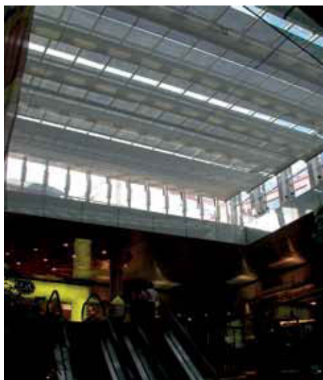
Sopra, particolare di un sistema di schermatura a tenda esterna mobile (cortesia di Griesser SA).
