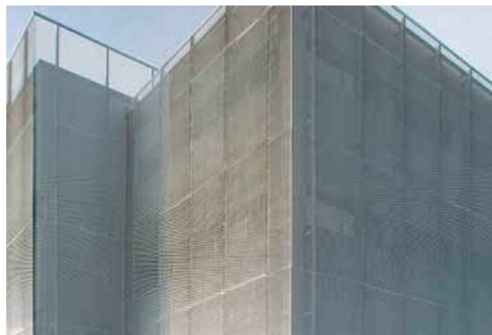
Università Bicocca, Milano, Studio ODA Associati. Sistema di schermatura in lamiera stirata in alluminio anodizzato (foto di Luca Capecci, cortesia di Italfim).
