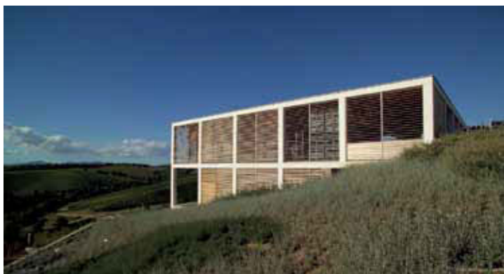
Cantina Collemassari , Cinigiano, Grosseto, arch. Edoardo Milesi. Sistema di schermatura a lamelle in legno (cortesia di Merlo).
