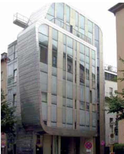
Bender , fronte sud-est dell'edificio.
