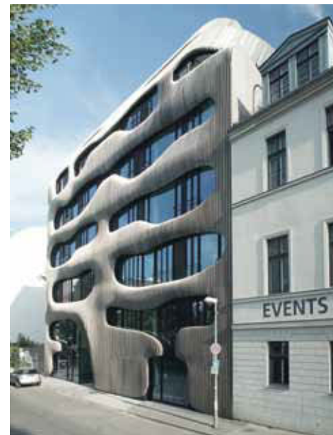
JOH3, fronte nord con l'ingresso e l'accesso ai garage. Foto di L. Paffrath.
