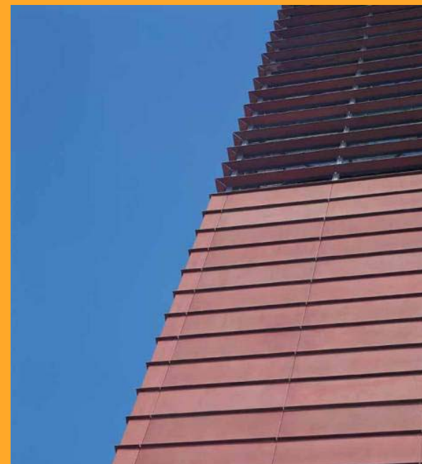
8. Particolare del rivestimento nel punto di passaggio tra i pannelli compositi rivestiti in rame 1mm con lamella inferiore e le sole lamelle sostenute da una gabbia metallica nella parte sommitale dell'edificio.
