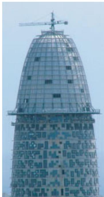
Il 19 gennaio 2004, una gru è stata installata nel centro della cupola d'acciaio per sostituire quella principale. Questa gru è stata utilizzata per alzare i materiali della cupola e delle facciate.
