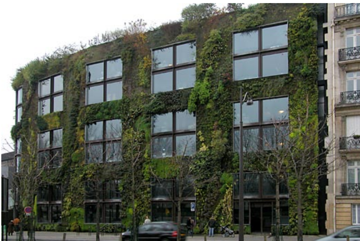
Figura 5_Musee Quai Branly, Parigi, Jean Nouvel. La chiusura verticale del blocco degli uffici disposto lungo la Senna si presenta rivestita sia esternamente che internamente da una vegetazione molto eterogena, nella foto da poco messa a dimora.
