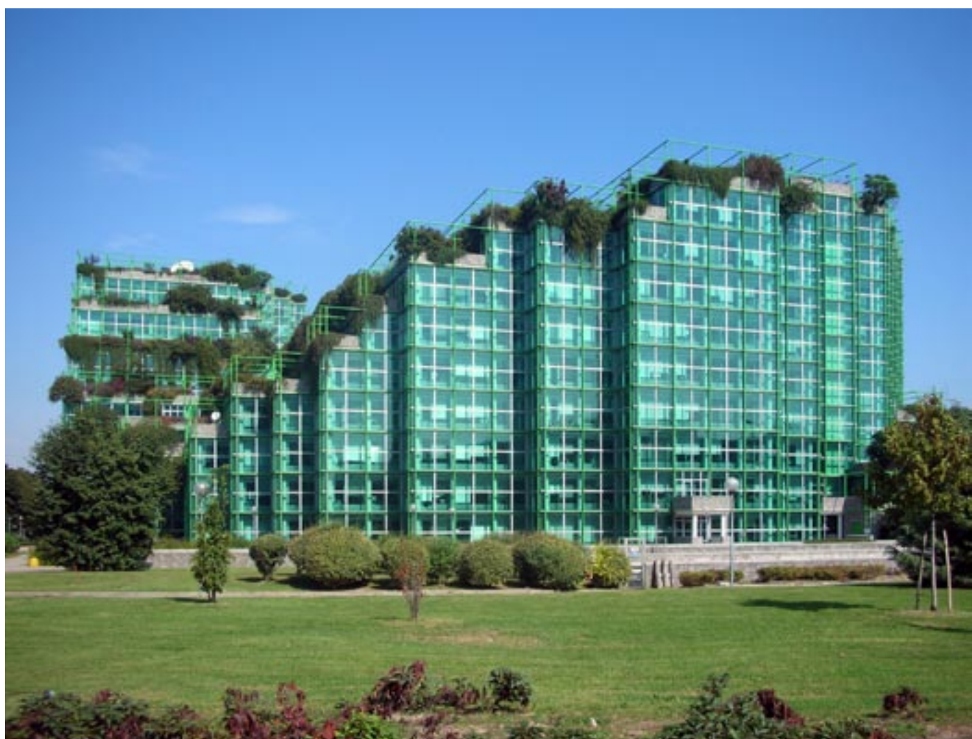
Figura 3_ Quinto palazzo per uffici Snam, S. Donato Milanese, Gabetti e Isola, 1986-1991. Oltre ai tetti pensili era previsto l'inserimento di piante all'interno della doppia facciata vetrata, vera e propria serra, per la quale era stata chiesta la consulenza dell'Istituto di coltivazioni arboree dell'Università di Bologna. In realtà solo poche piante sono state realmente introdotte nell'intercapedine, che si è preferito lasciare libera e destinare alla manutenzione degli impianti e della facciata stessa.
