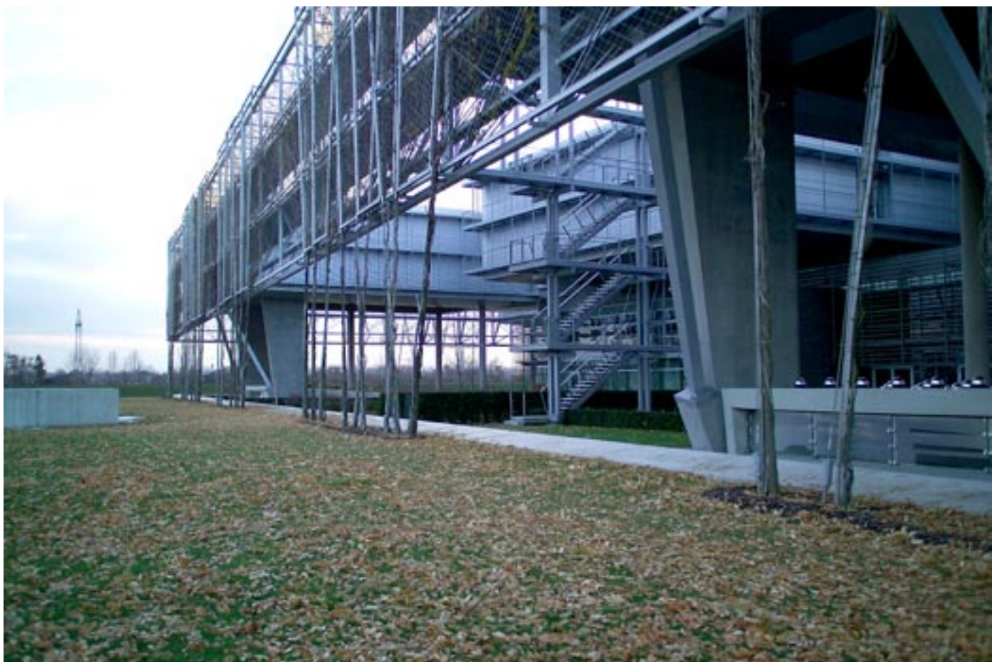
Figura 4_ Sede Re Swisse, Monaco, BRT Architekten. Il muro di sostegno delle passerelle è schermato da una rete metallica che supporta l'edera rampicante, i cui tralci si avvolgono agli stralli della struttura.
