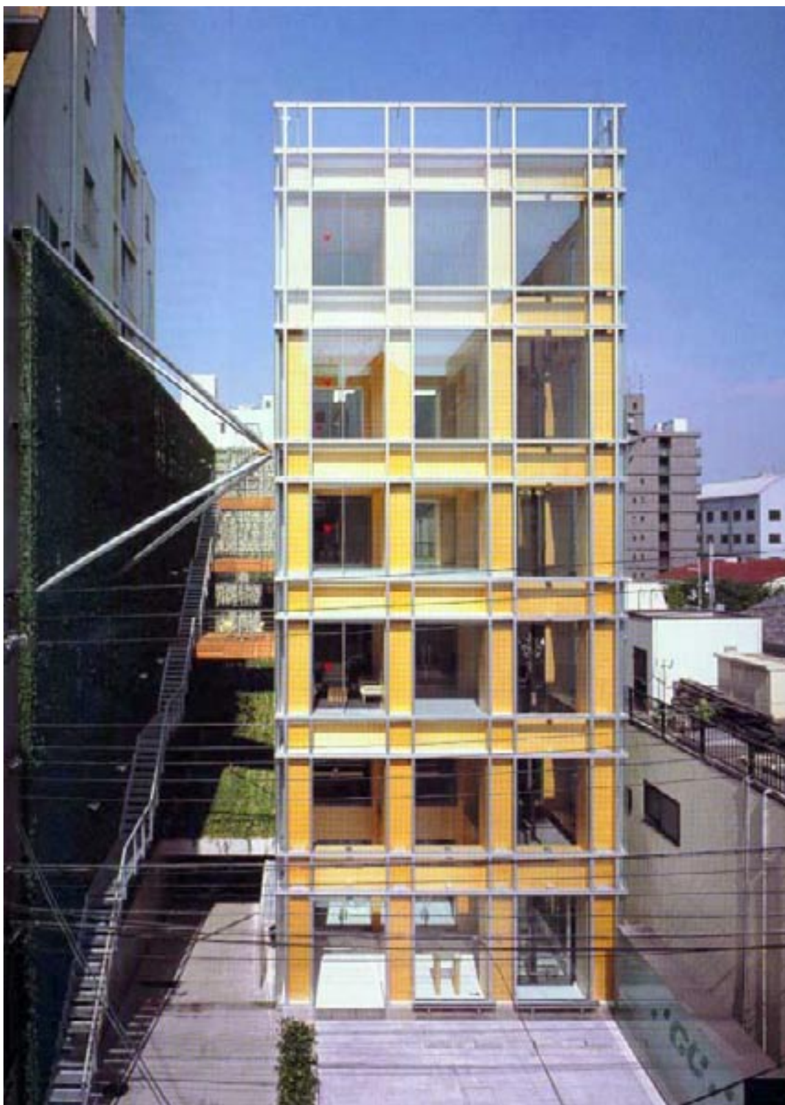
Figura 2_Edificio per uffici GC, ad Osaka, Shigeru Ban. La scala di sicurezza esterna della palazzina per uffici viene addossata ad un muro in grigliato metallico rivestito di rampicanti. In questo modo si scherma la facciata dell'edificio preesistente e si conferisce al collegamento verticale una qualità non solo funzionale.
